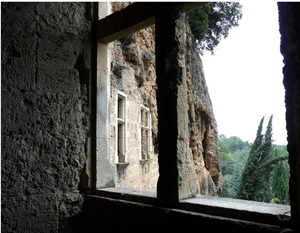
Fig. 1 : Les belles fenêtres à meneau de la façade.
