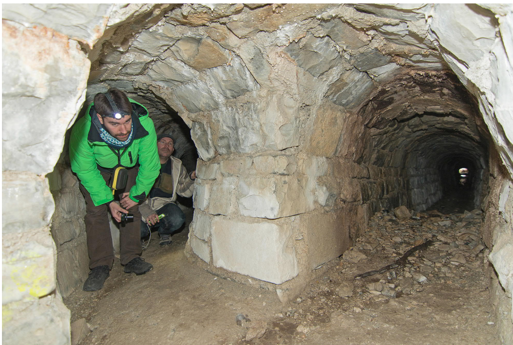
Fig. 1 : Le carrefour G3/G2 vu de l'amont : dans G2 aval, à droite, on distingue le cône d'éboulis et l'arrivée du busage de P2 en voûte, et, au fond, la zone de sortie semi-ennoyée. La photo a été prise lors du repérage pour le documentaire de Félix Besson, Chemins de traverse (Cliché O. Joseph).
